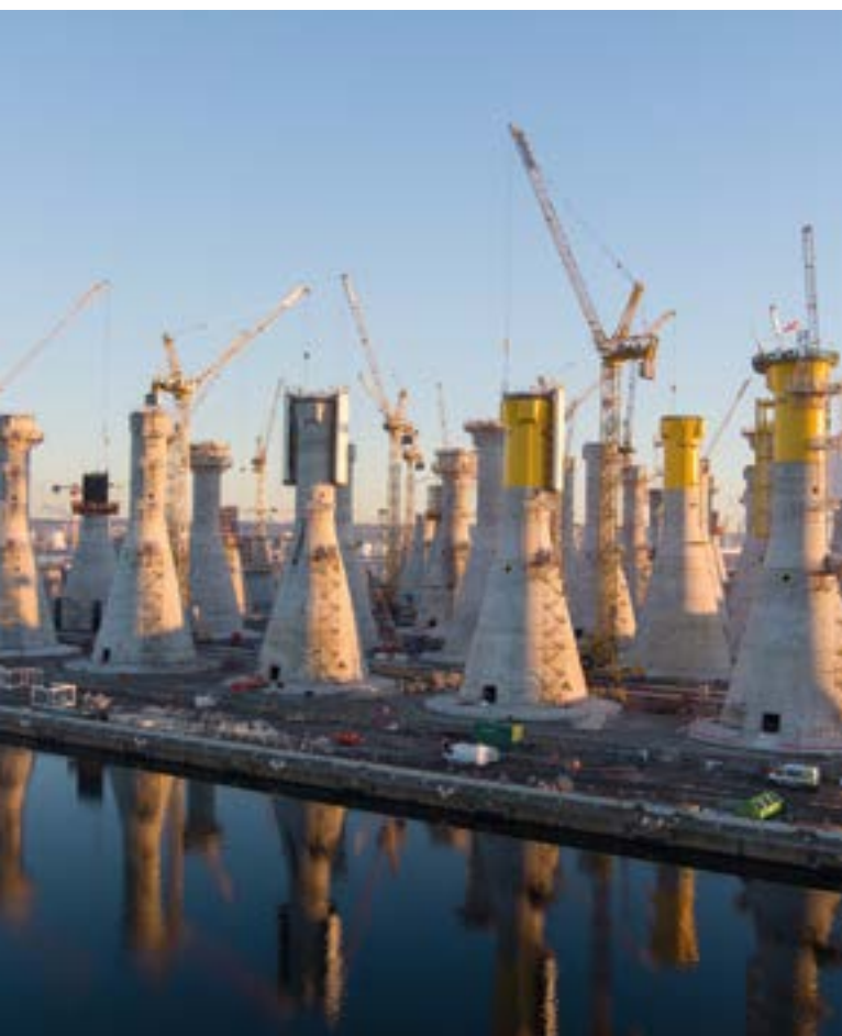
Chantier des fondations gravitaires au Havre
