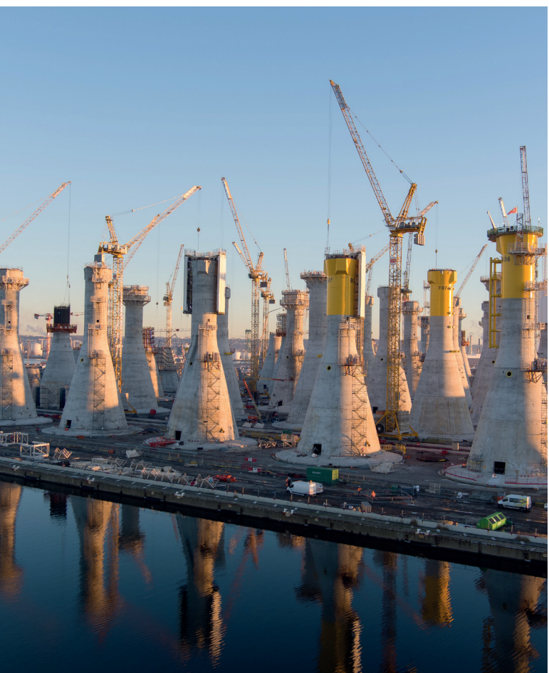
Chantier des fondations gravitaires au Havre
