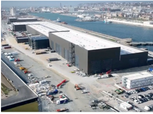
Usine de Siemens Gamesa Le Havre
