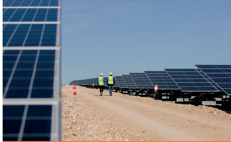
Centrale solaire de Dijon-Valmy (Bourgogne-Franche-Comté) - 16 MWh : construite sur un ancien centre d'enfouissement technique, les panneaux sont posés sur des structures conçues pour respecter l'intégrité de la couche de terre végétale posée sur le centre.
