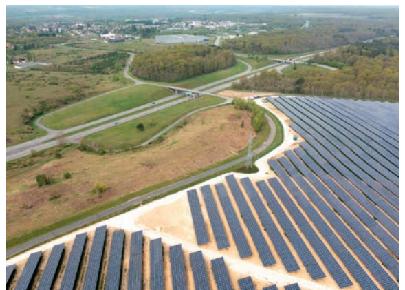
Centrale solaire de Briare (Centre-Val-de-Loire) - 15,5 MWh : elle contribue à la revalorisation d'un délaissé autoroutier, dans une démarche d'accompagnement du territoire dans sa transition énergétique.
