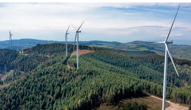
Parc éolien du Beaujolais Vert (Auvergne-Rhône-Alpes) – 12 MW : premier parc éolien du Rhône, développé en étroite collaboration avec le territoire, il s'inscrit dans la démarche locale de Territoire à Énergie Positive.
