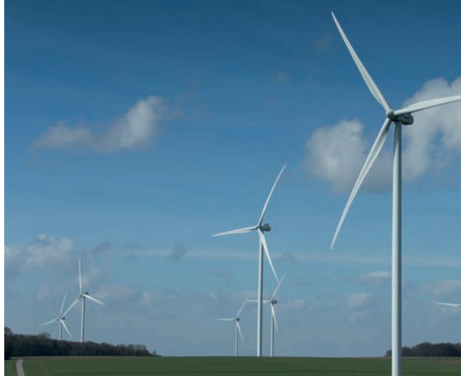
Parc éolien de Champagne-Picarde (Hauts-de-France) – 73 MW : composé de 22 éoliennes Vestas de 3,3 MW de puissance unitaire, il est parcs éoliens terrestres exploités par EDF Renouvelables en France.
