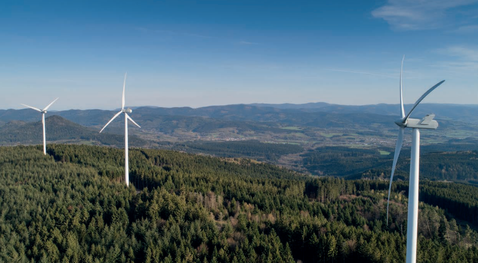
Parc éolien de Belfays (Grand-Est) - 20 MW
