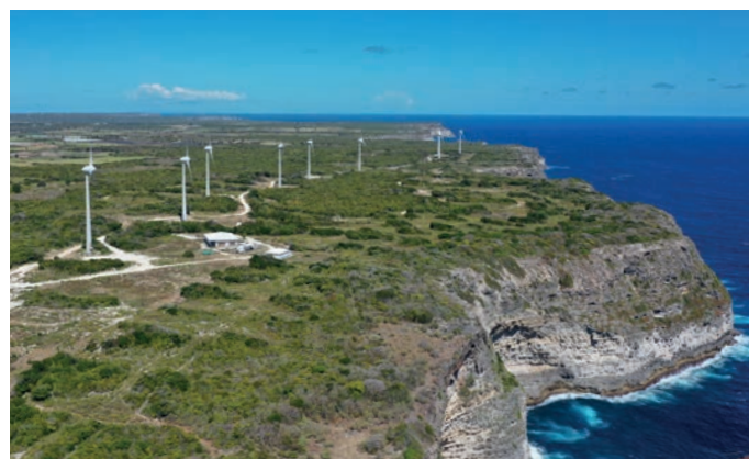
Parc éolien de Petit Canal (Outre-Mer) – 9MW : le parc de Petit Canal a fait l'objet d'un repowering en 2020 : le nombre d'éoliennes a été réduit de 32 à 10 pour un gain de puissance de 7 à 9 MW.
