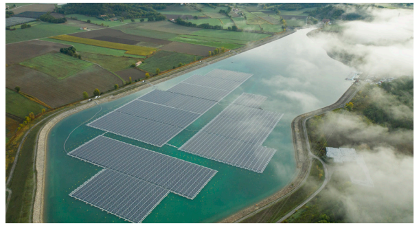
Centrale solaire flottante de Lazer (05) en construction
