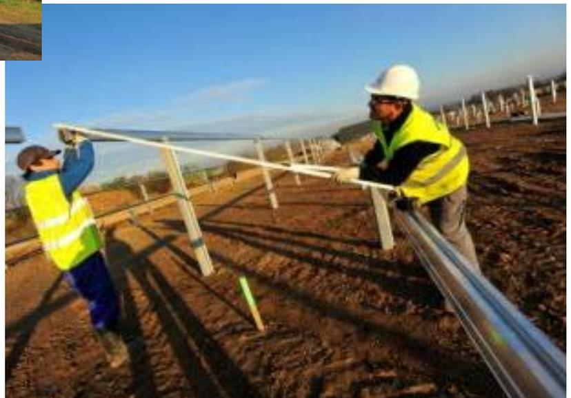
Pose des **structures** et fixation d'1,4 millions de **panneaux photovoltaïques**
