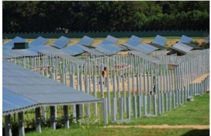
Pour tenir les délais, **les travaux se sont déroulés simultanément** : des panneaux sont posés sur une tranche tandis que les structures sortent de terre sur une autre.
