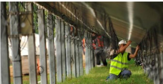
**Raccordement électrique** des panneaux aux onduleurs puis de la centrale au réseau électrique. Tous les équipements sont ensuite testés avant que la centrale **entre en service**.
