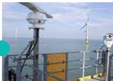
Un radar a été installé sur l'éolienne centrale. Les données récoltées seront analysées pour décrire plus finement les interactions entre la faune volante et les éoliennes.
